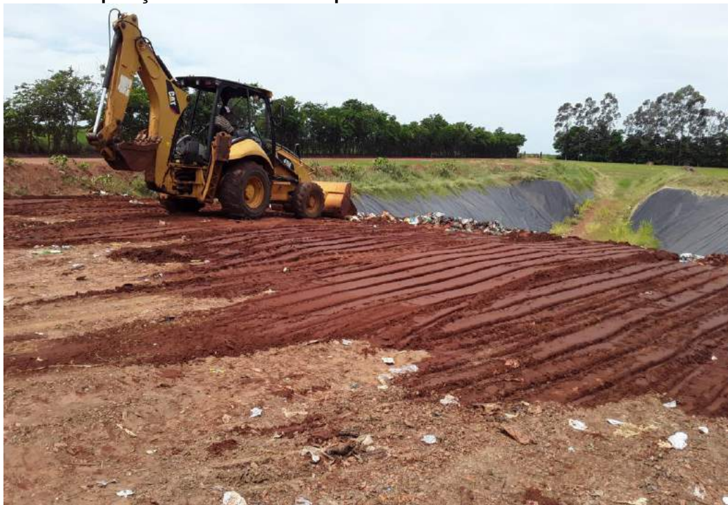
FOTO 6 - Operação das trincheiras impermeabilizadas do Aterro Sanitário
