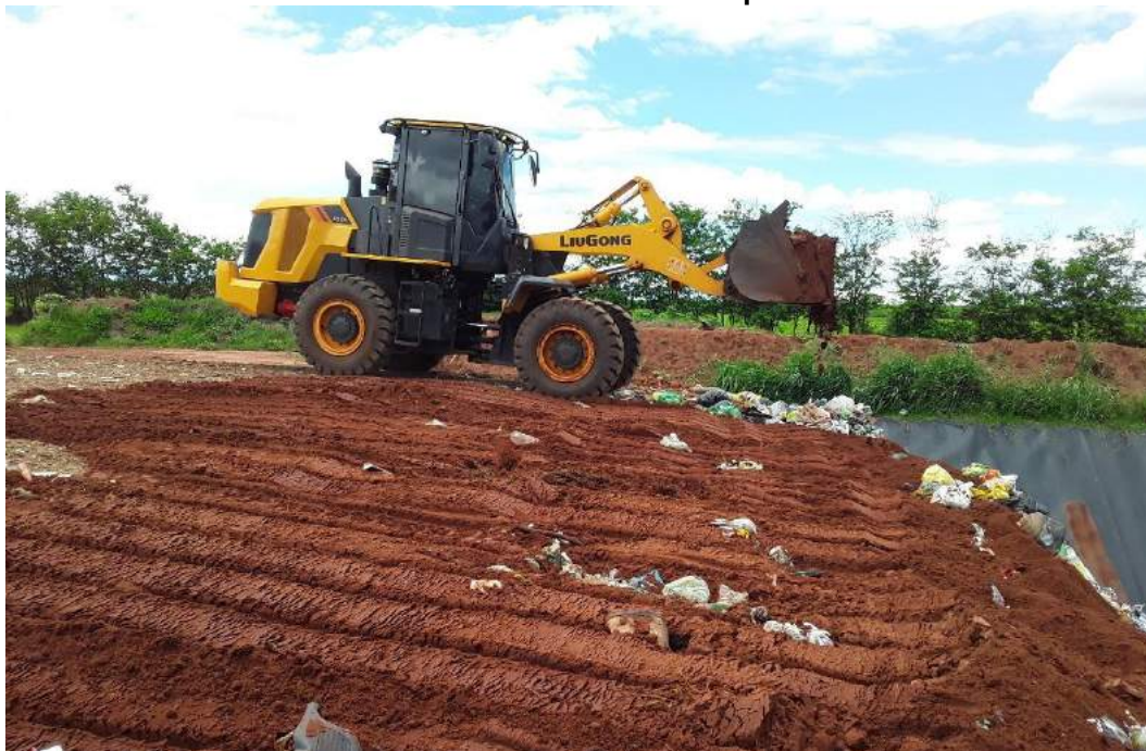
FOTO 7 - Recobrimento dos resíduos na trincheira impermeabilizada
